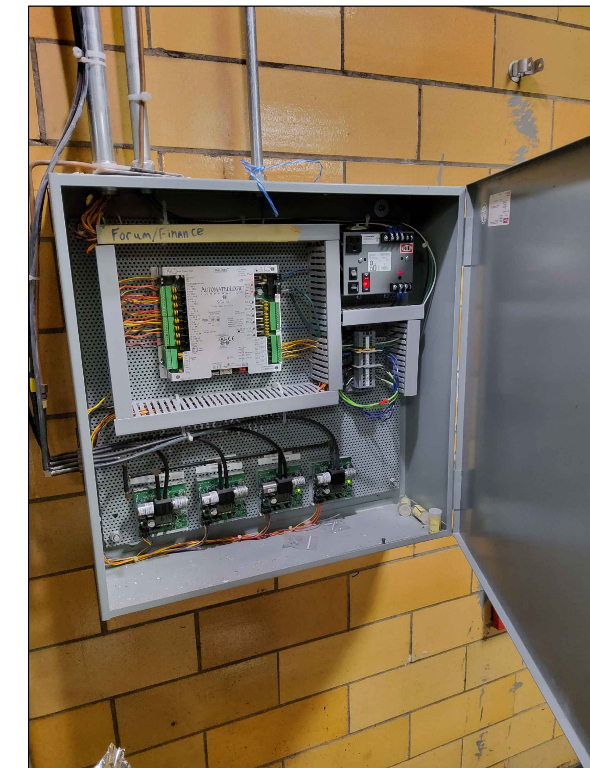
10 PHOTO: ECP M-5 Scale: NONE
